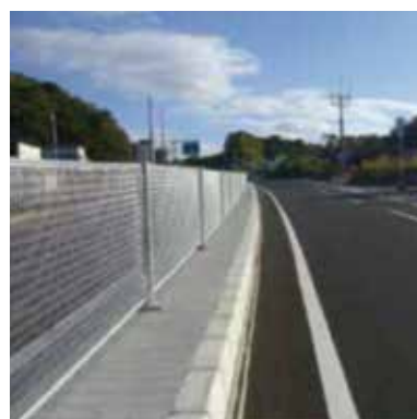
中央分離帯 (国道170号大阪府和泉市)
