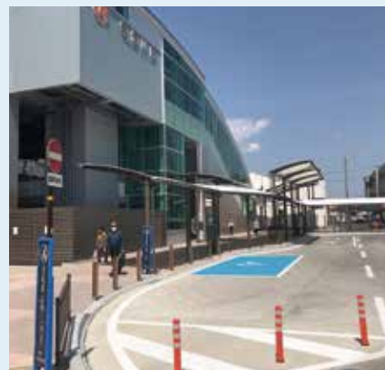
静岡県静岡市 安倍川駅ロータリー
