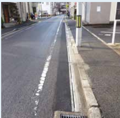
愛知県豊田市 道路維持修繕工事
