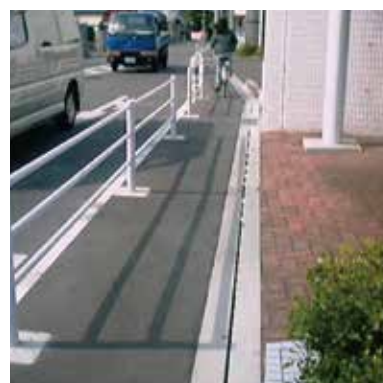
歩道整備事業 (大阪府阪南市)
