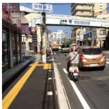
電線共同溝 (国道176号大阪府豊中市)
