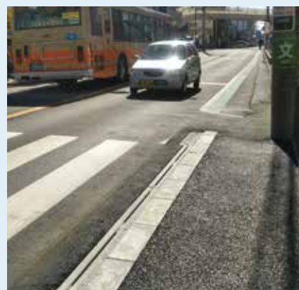
神奈川県横浜市 管内道路整備工事
