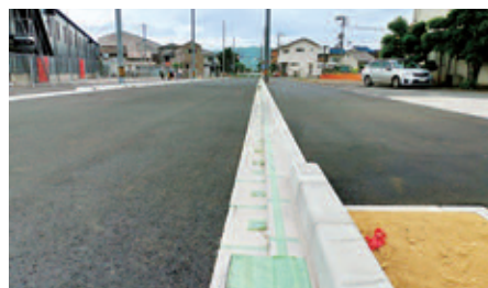
広島県福山市(舗装前)
