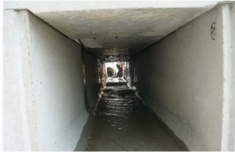
排水孔からの排水状況 製品設置状況及び排水状況
