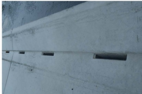
排水状況(車道乗入タイプ) 排水状況
